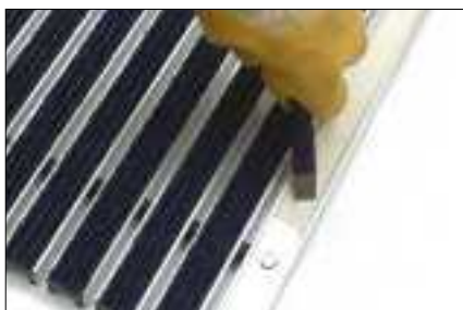
Con un comune cacciavite staccare l'inizio della striscia di reps dal profilo di alluminio e rimuoverla.
